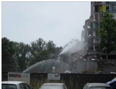
Abbildung 27: nasse Arbeitsweise bei Abbrucharbeiten
