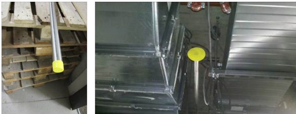
Abbildung 18: Beispiel für den Verschluss montierter Rohrleitungen
