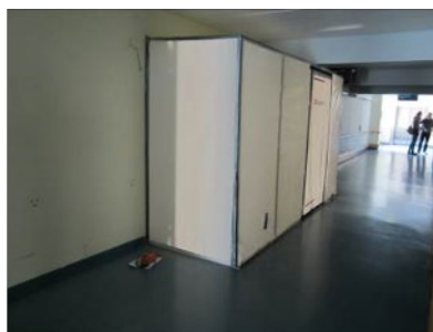
Abbildung 24: Positivbeispiele Staubschutzfolien
