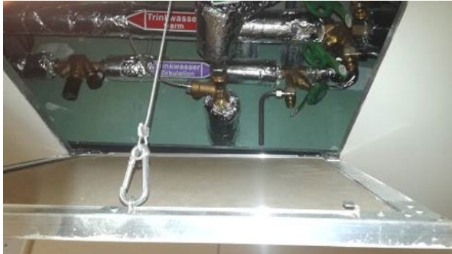
Abbildung 19: Negativbeispiel für den Einbau von Probennahmeventilen
