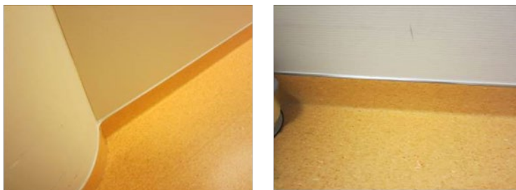
Abbildung 16: Beispiel für die Anbindung Fußboden-Wand
