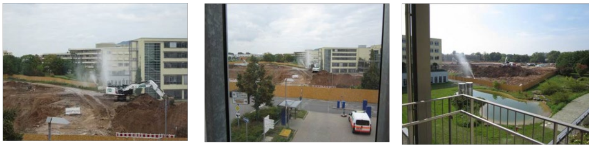
Abbildung 29: mögliche Bewässerung während des Bodenaushubs
